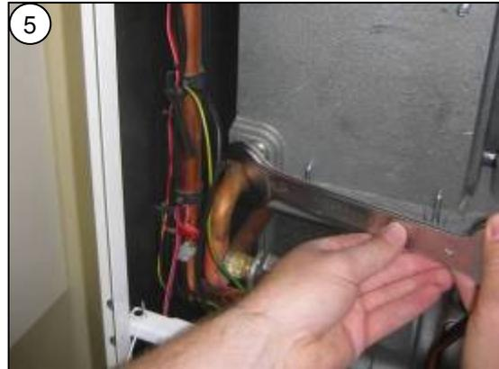
5 Verschraubungen Vor- und Rücklauf am Wärmetauscher lösen
