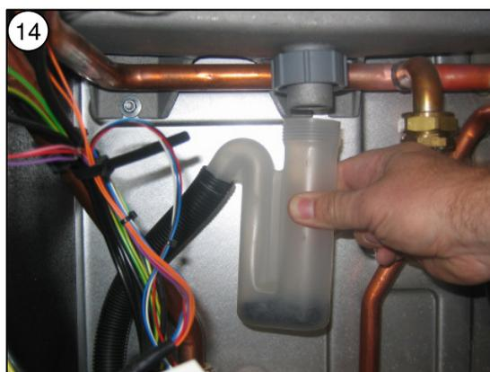
14 Siphon auf Verschmutzung prüfen, evtl. vor weiteren Arbeiten reinigen, dazu Überwurf lösen und Siphon abziehen
