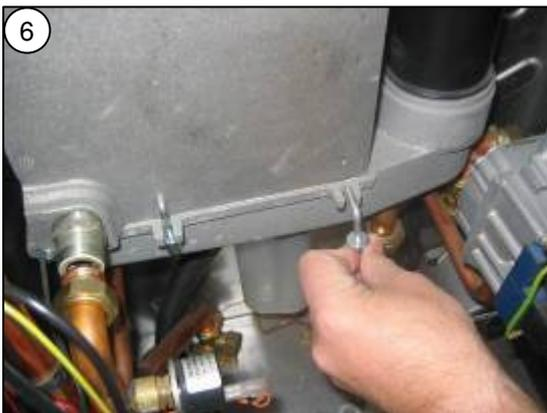
6 Spannhaken an der Sammelschale lösen und nach vorne abziehen
