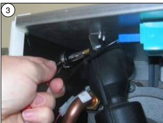
3 Sicherungsschraube des Ansaugschalldämpfers lösen, Ansaugschalldämpfer abziehen und aus Gerät entnehmen
