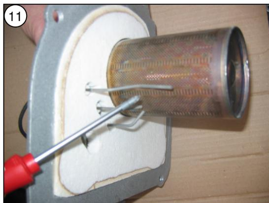
Elektrodenblock, Brennerisolierung und Brenner auf Abnutzung und Lage prüfen!
