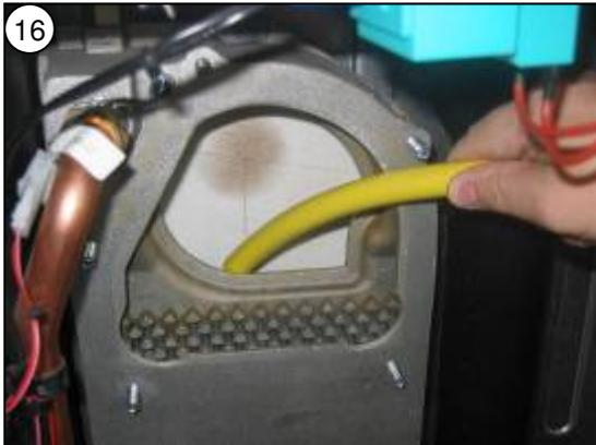
der Reiniger muss gründlich aus dem Wärmetauscher ausgespült werden!
