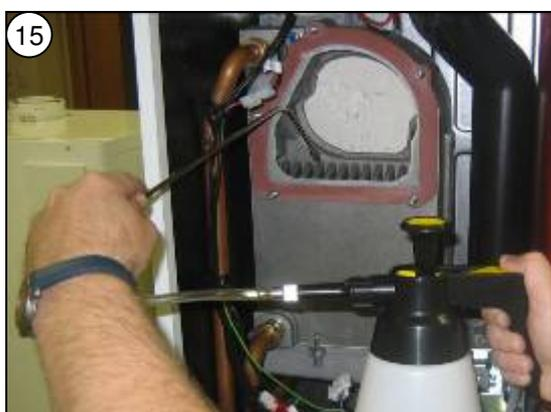
Vor allen weiteren Arbeiten zunächst den Feuerraum des Wärmetauschers **von oben** absaugen!
