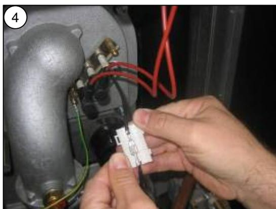
4 Isolierschale des Verbindungssteckers vom Ionisationsstromkabel lösen, Stecker trennen
