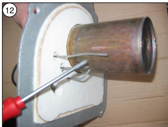
12 Elektrodenblock, Brennerisolierung und Brenner auf Abnutzung und Lage prüfen!
