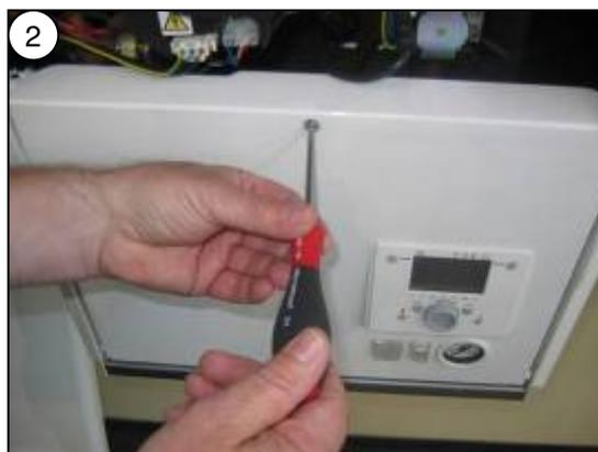
2 Sicherungsschraube des Schaltfeldes lösen und Schaltfeld wegklappen
