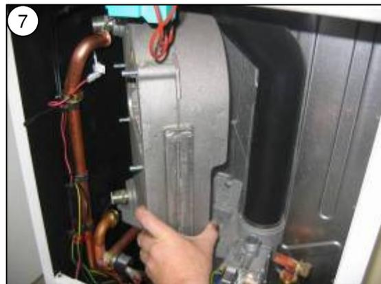
7 Wärmetauscher leicht kippen und im Uhrzeigersinn um ca. 45° drehen, danach aus Gehäuse entnehmen
