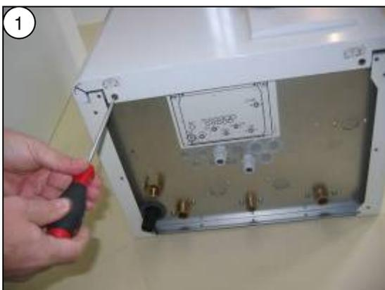
1 Sicherungsschrauben der Verkleidung im Uhrzeigersinn drehen (bei BBS und BBK von oben!), Verkleidung abnehmen
