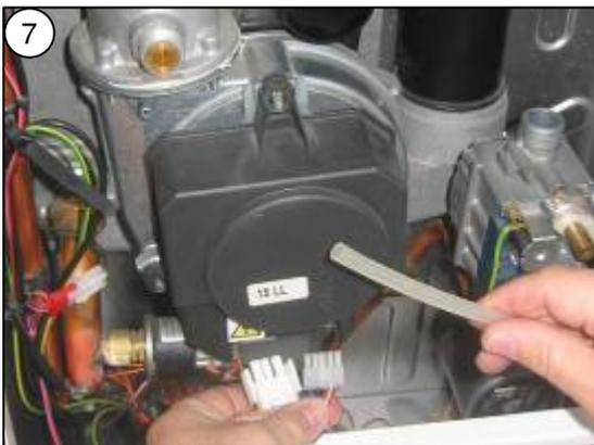
7 Druckverbundschlauch und Stecker am Lüfter abziehen
