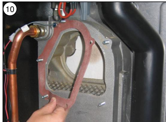
10 Brennerdeckeldichtung entfernen und Dichtflächen ggf. reinigen
